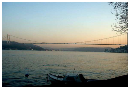
Istanbul – ponte sul Bosforo
